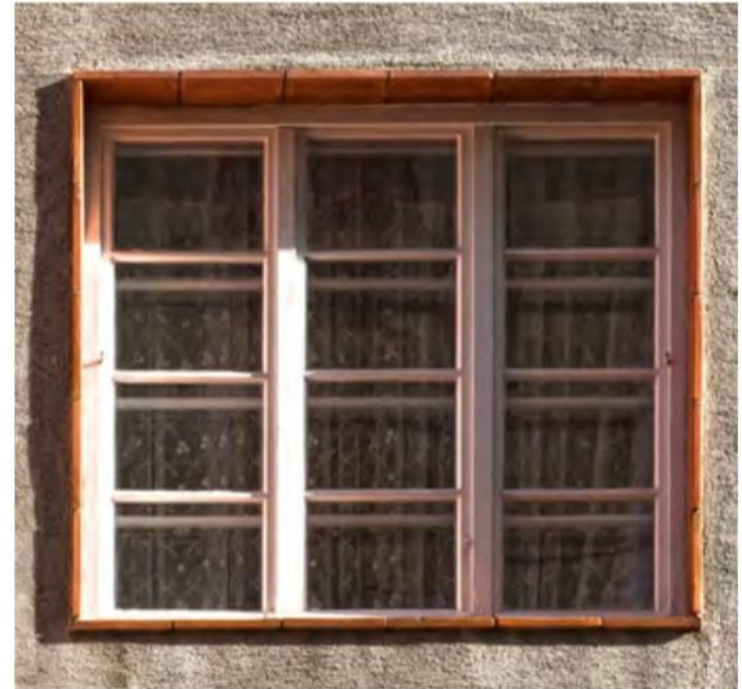
Weißfassung: Normtypus-Kastenfenster des Roten Wiens, 1929.
