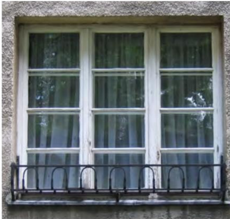
1150, Wurzbachgasse 2-8. 1926. Normtypus zweiflügelig u. dreiflügelig mit Vierfachteilung. Originalfenster trotz Denkmalschutz heute nicht mehr vorhanden.
