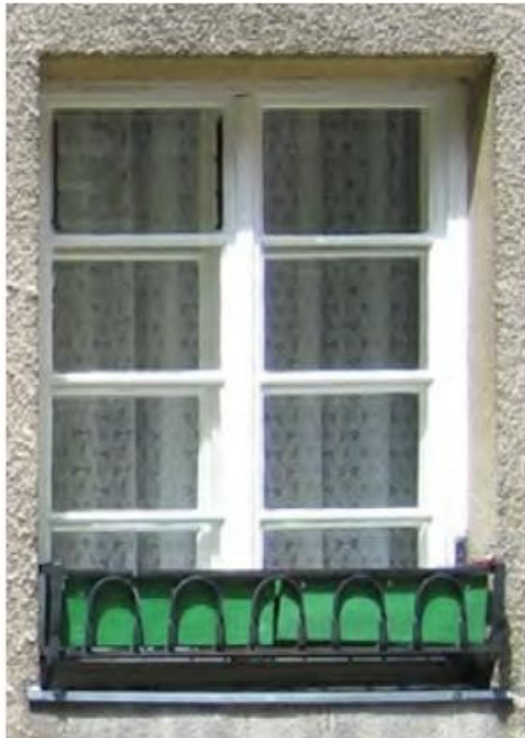
1150, Wurzbachgasse 2-8. 1926. Normtypus zweiflügelig u. dreiflügelig mit Vierfachteilung. Originalfenster trotz Denkmalschutz heute nicht mehr vorhanden.
