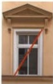
1936, Salzkammergasse 17. Fenstertausch redifika Stöckerränge.
