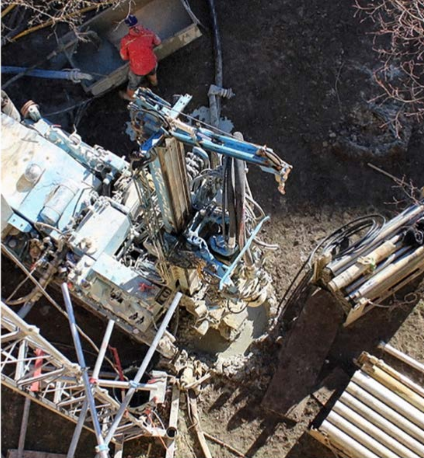
Erdsonden-Tiefenbohrung für die Wärmepumpen-Installation (Volksgasse im 13. Bezirk)
