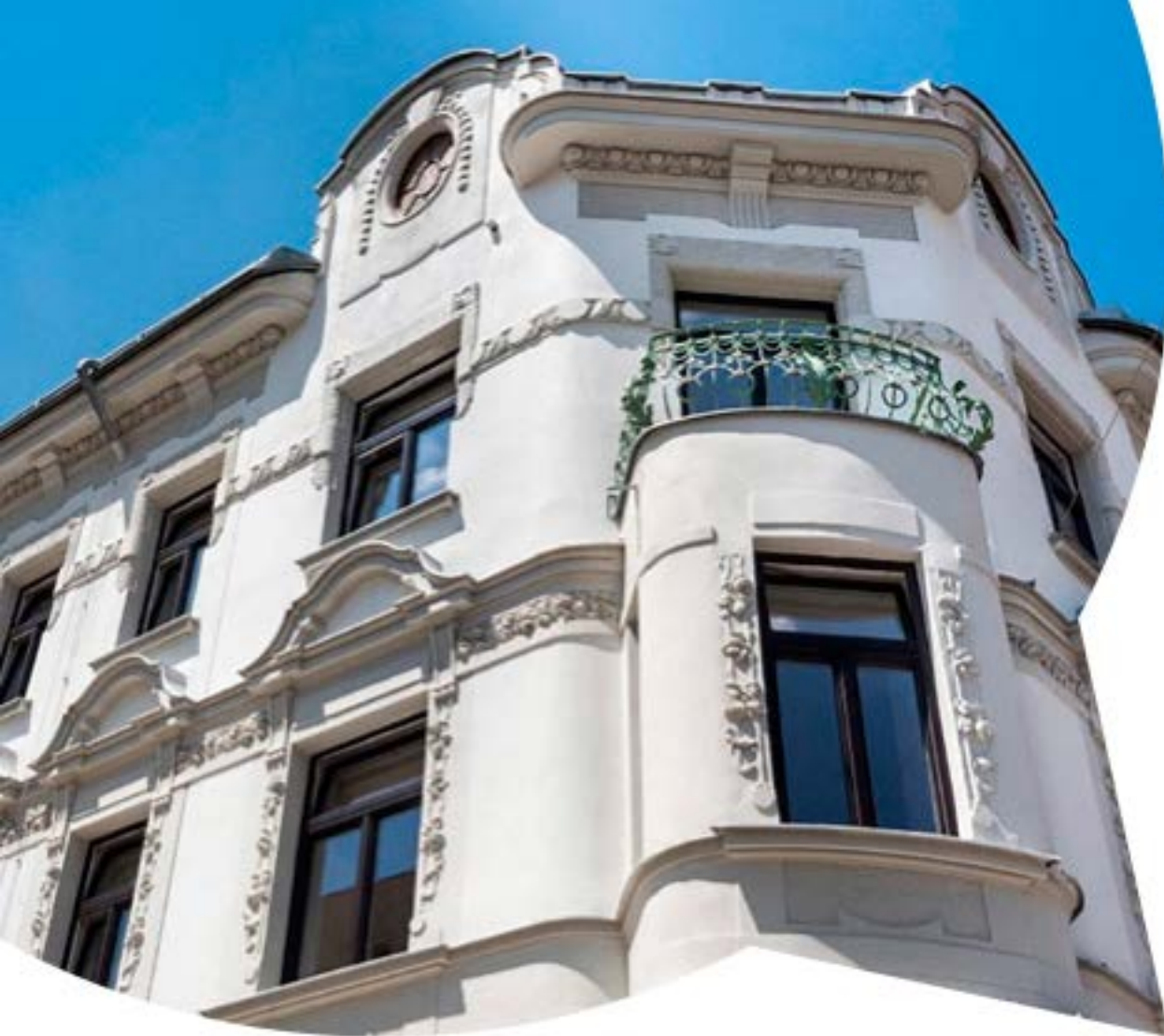
Fenstersanierung im Jugendstil-Haus (Bunsengasse im 21. Bezirk)
